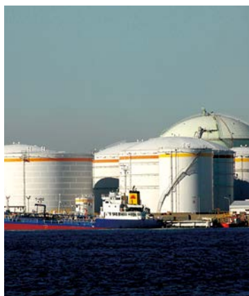
LNG プラント
